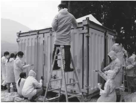
写真5 用具倉庫となるコンテナ設置とその装飾の様子 (2013年11月3日・4日)
